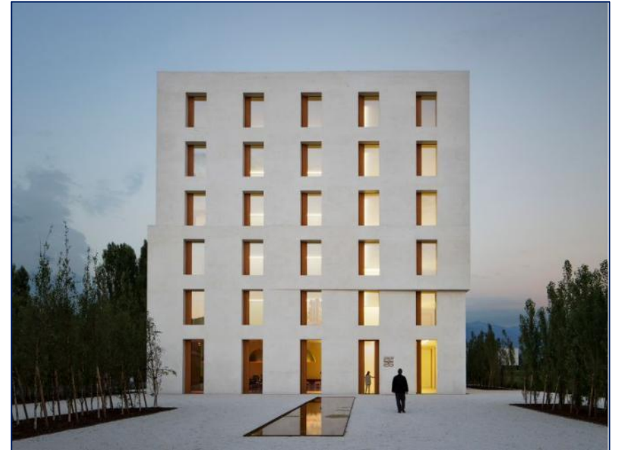
Un bâtiment sans chauffage ni climatisation toute l'année. Crédit photo : BE - Baumschlager Eberle © Eduard Hueber
