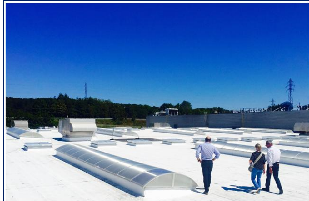
Toiture du Leclerc de Quimper
